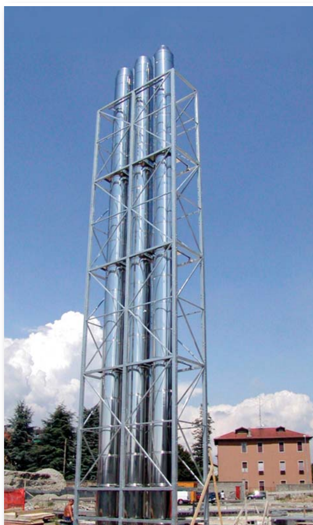
Esempio di installazioni di camini singoli Poliedra con reticolo di supporto funzionanti in classe P1 ed asservite a generatori a condensazione
