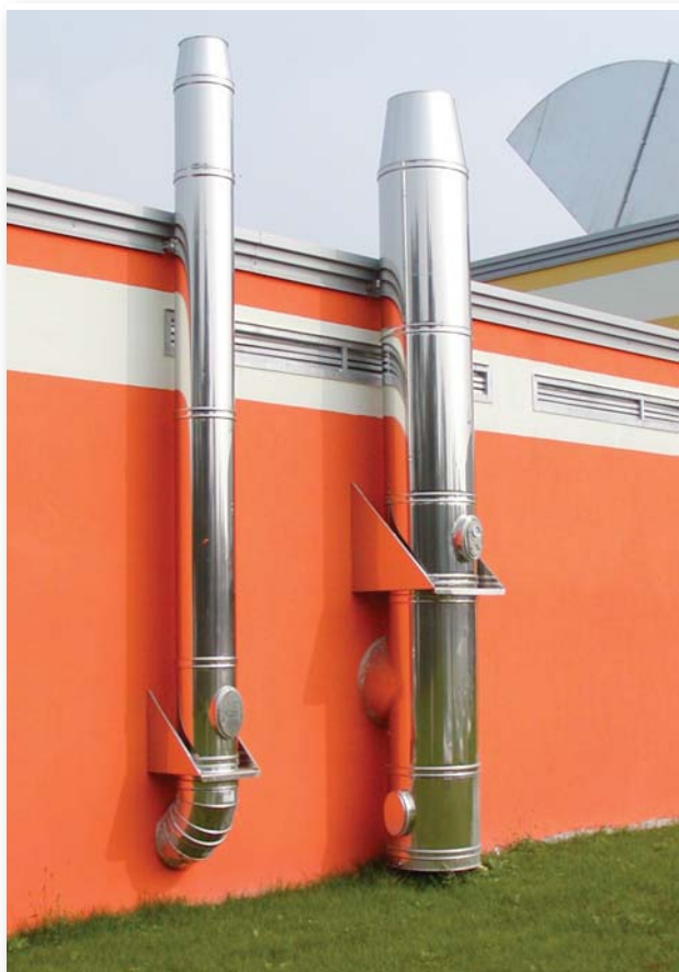
Esempio di installazione di canna fumaria Poliedra
